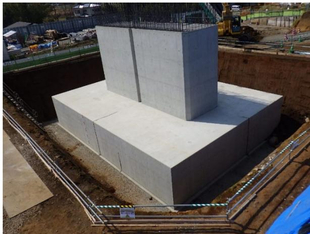
図2-1 埋戻し前の杭基礎フーチング
