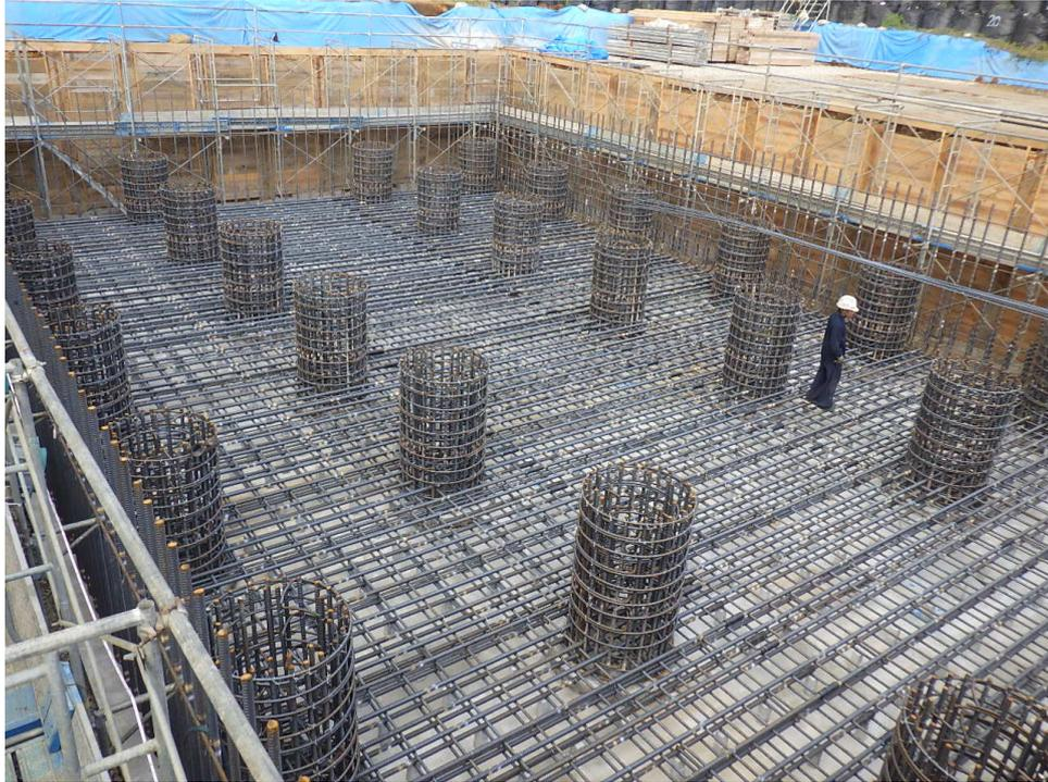
図 2-9 フーチング下側鉄筋と杭基礎鉛直方向鉄筋の配筋事例
