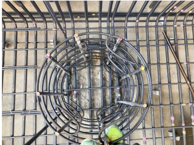
図 4-10 フーチング下側鉄筋配置完了
