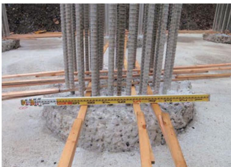
図 4-5 定規材設置状況<sup>2)</sup>
