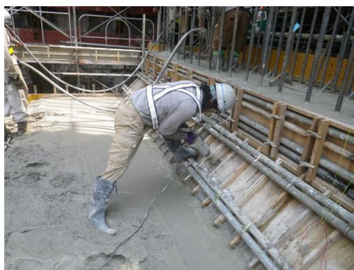
(b) ハンチ部コンクリート打設状況
