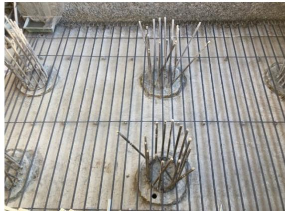
図 4-9 フーチング下側鉄筋配置状況
