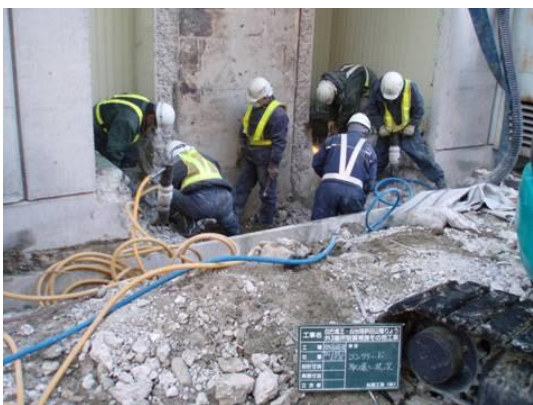
図-6.15 支障物撤去
