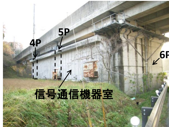
(a) 高架下利用状況
