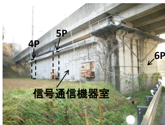
(a) 高架下利用状況
