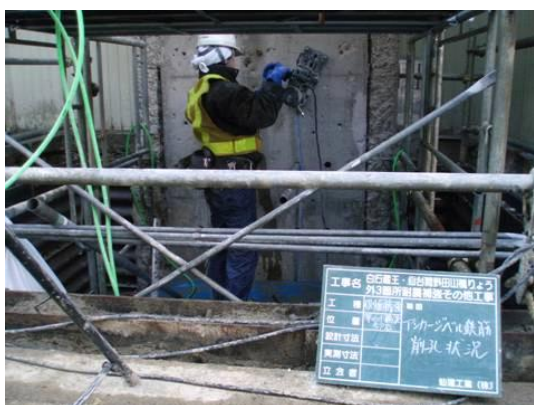
図-6.22 アンカー削孔
