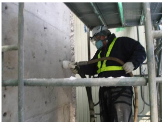
図-6.19 コンクリート表面のブラスト処理
