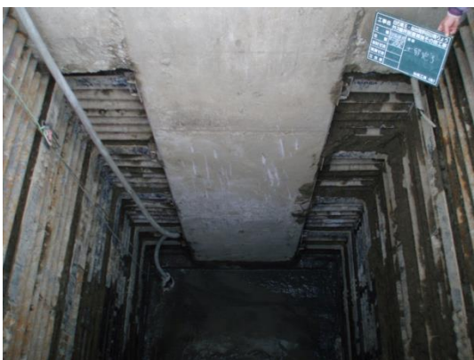
図-6.17 掘削土留工完了状況
