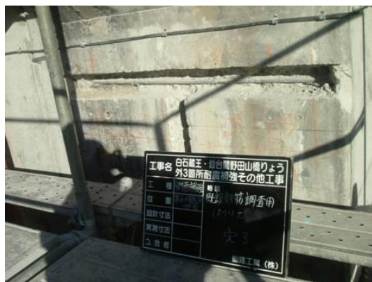
図-6.18 鉄筋探査はつり完了状況
