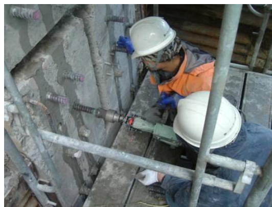
図-6.23 アンカー打込み
