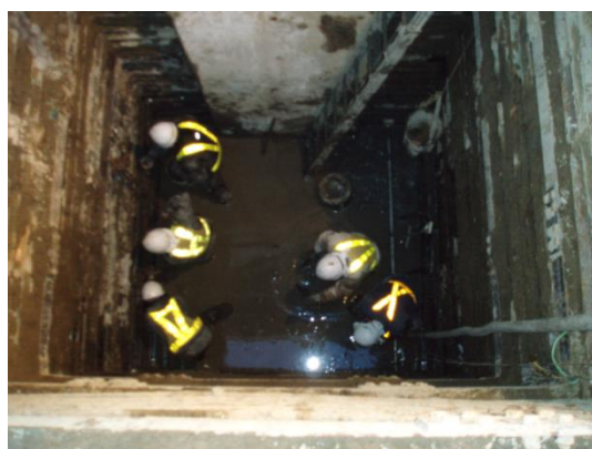
図-6.16 掘削土留工（地下水発生状況）
