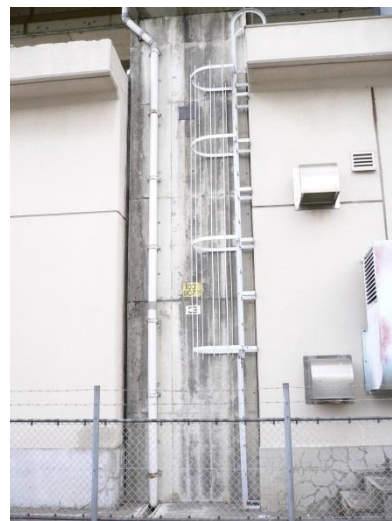
(b) 橋脚側面の状況
