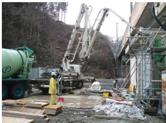
図-6.28 コンクリート打設状況
