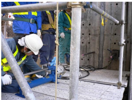
図-6.24 アンカー引抜き試験
