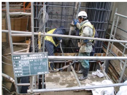
図-6.29 コンクリート打設状況
