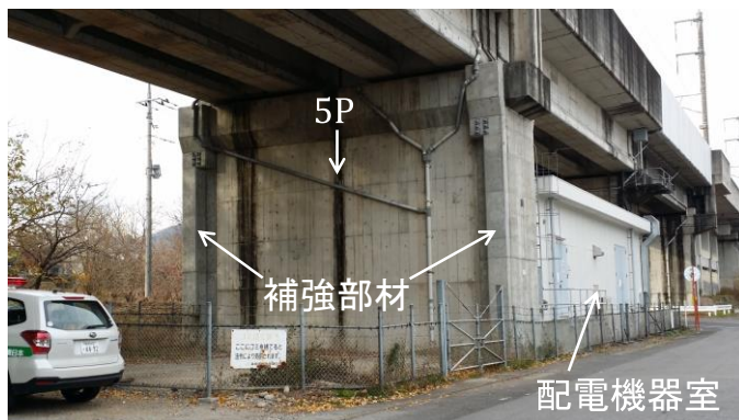
(b) 補強後の中大塚高架橋5P
