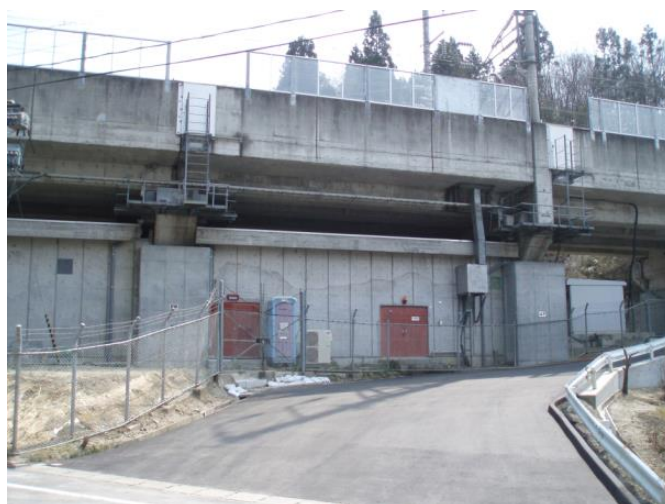
図-6.30 補強工事完成状況
