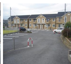
写真 5-21(アパートの駐車場)
